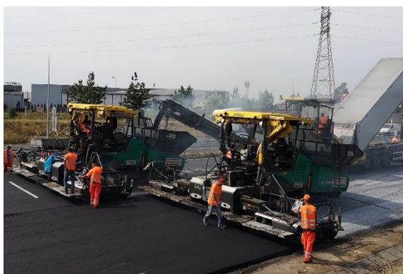
Układanie nawierzchni
