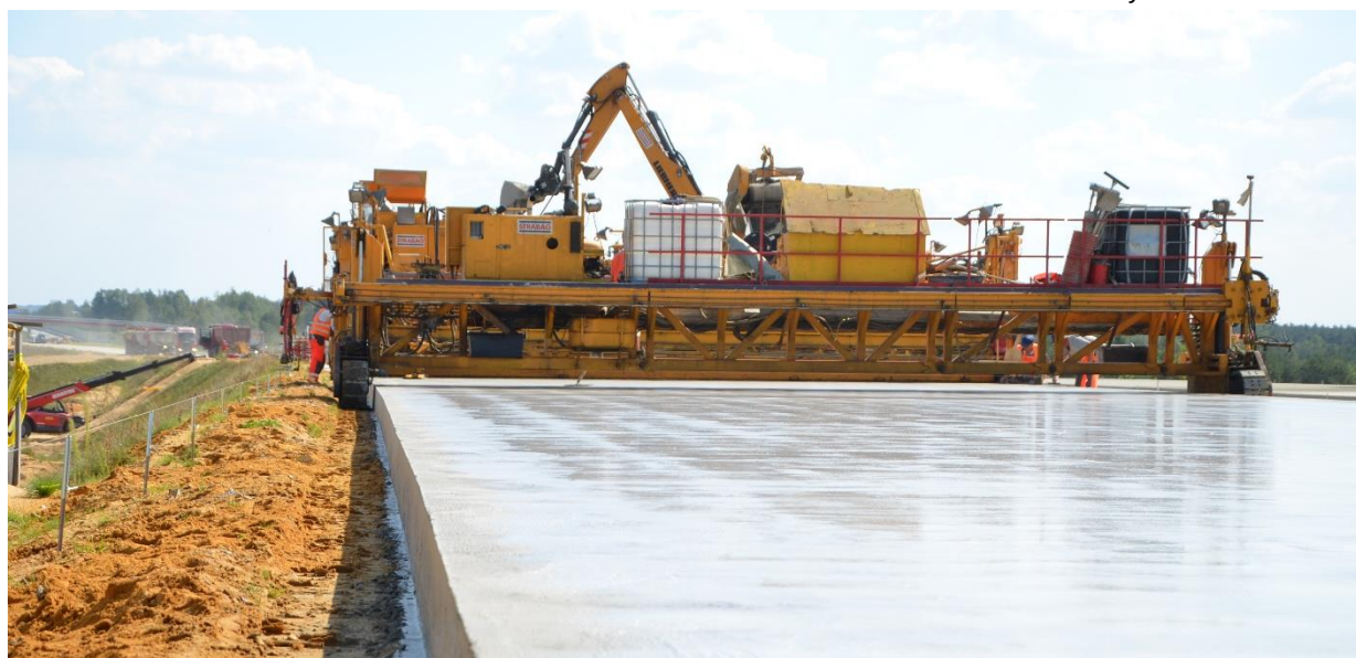
Prace na odcinku F autostrady A1
