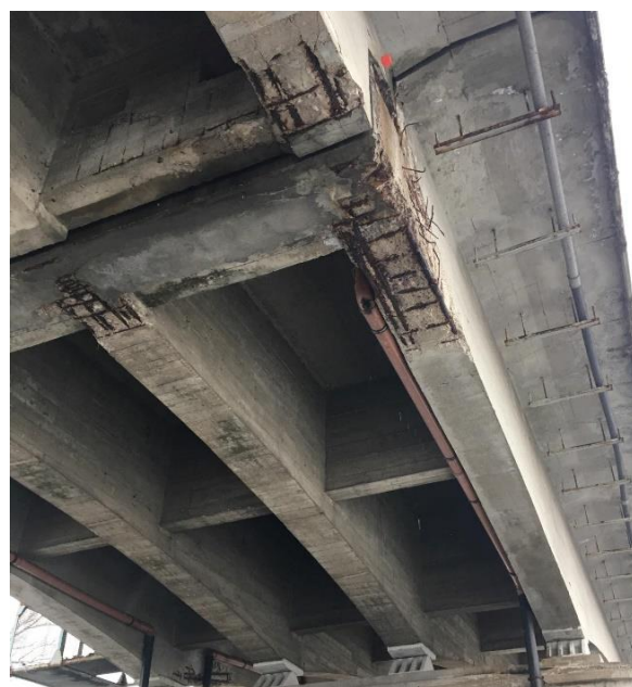
Stara konstrukcja mostu
