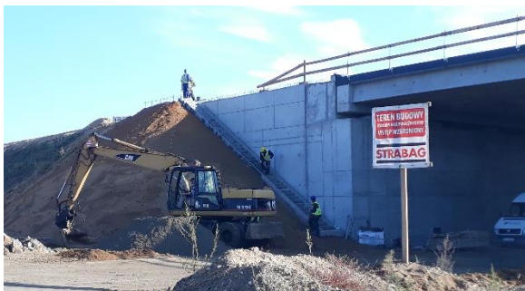
Prace na odcinku F autostrady A1
