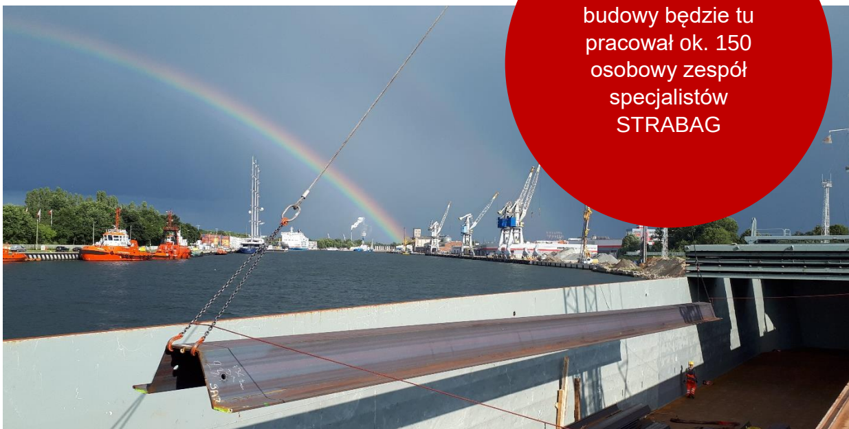
Rozładunek materiałów z pontonu transportowego
